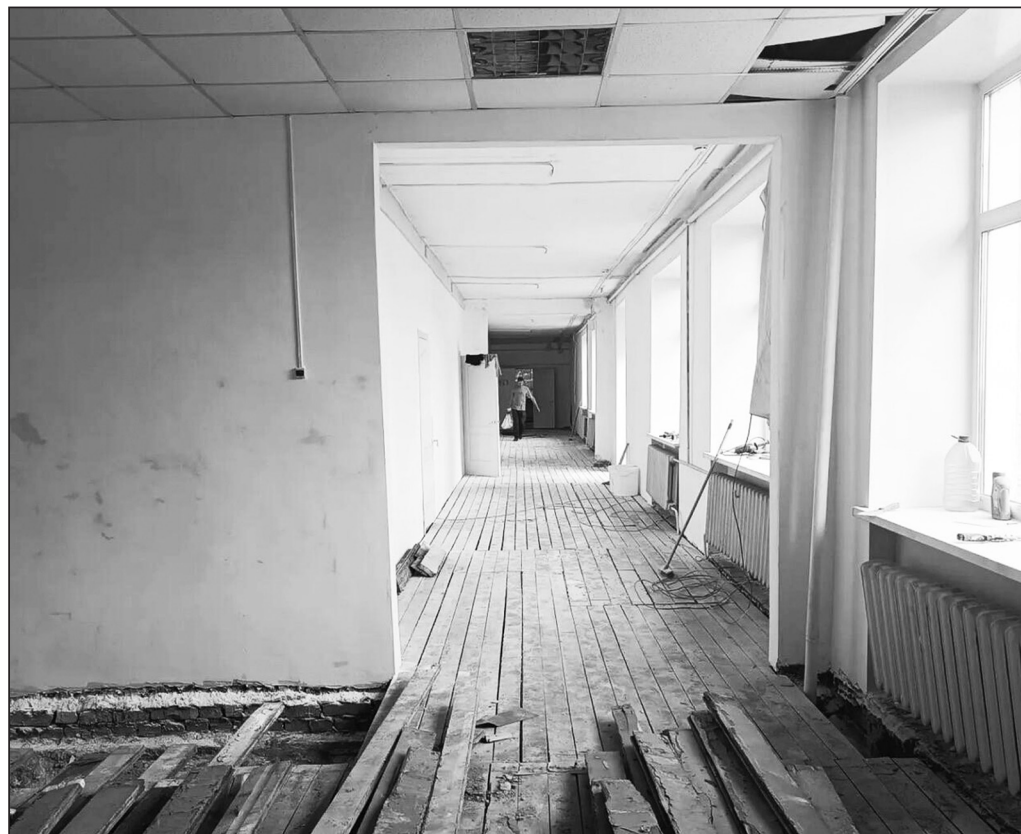
Ремонт идёт полным ходом
